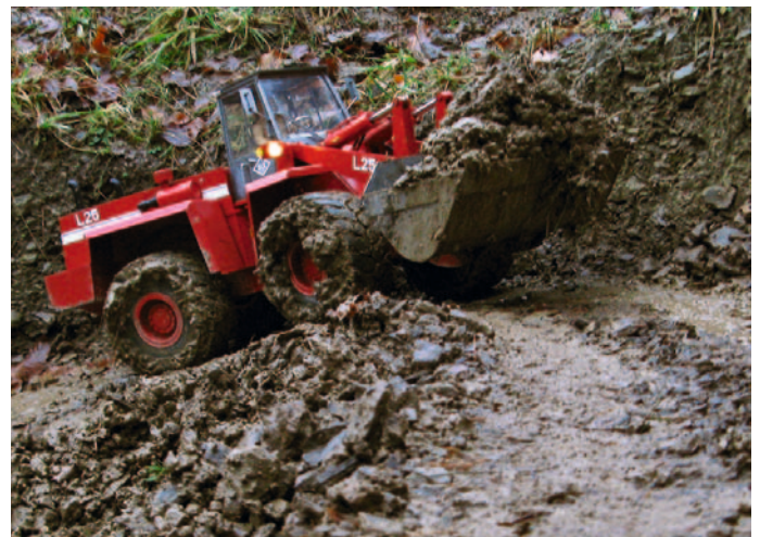
Auch bei Regen wurde der Ausbau stetig vorangetrieben
